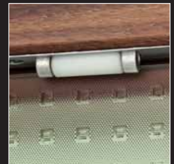
Rollenfallenschließblech in der Zarge
