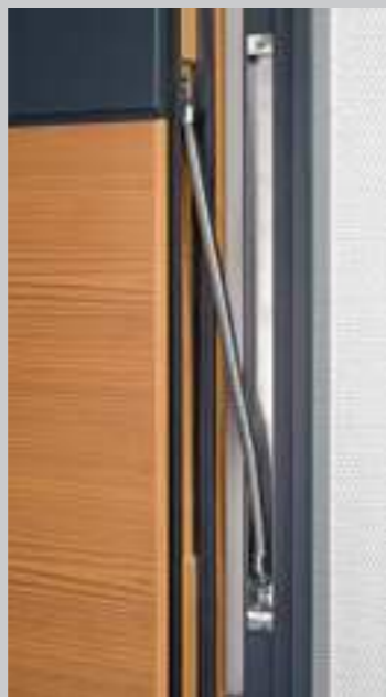
Stromversorgung für Automatikmotor mit metallarmiertem Flex-Kabel
